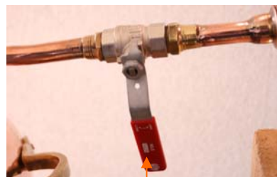
ヒーティングタンクのコック(閉じた状態)
